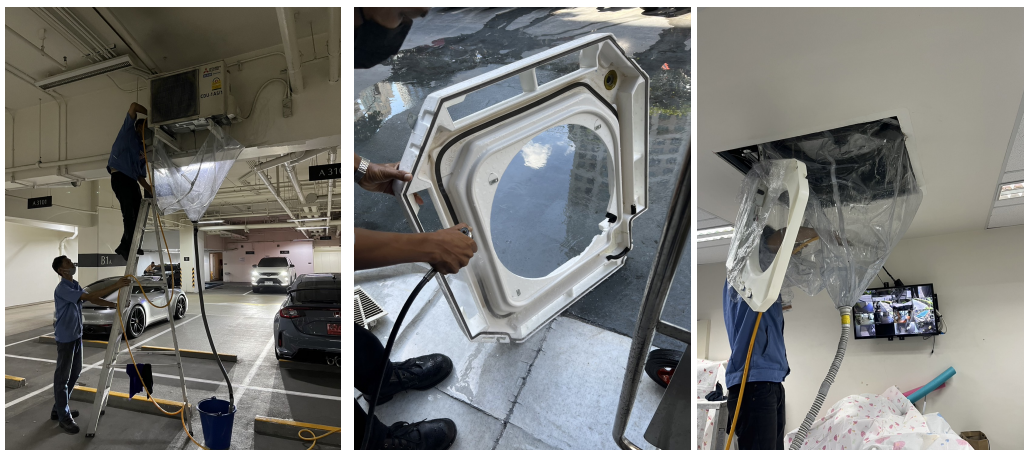
ภาพที่ 3-42 ล้างเครื่องปรับอากาศภายในอาคาร
