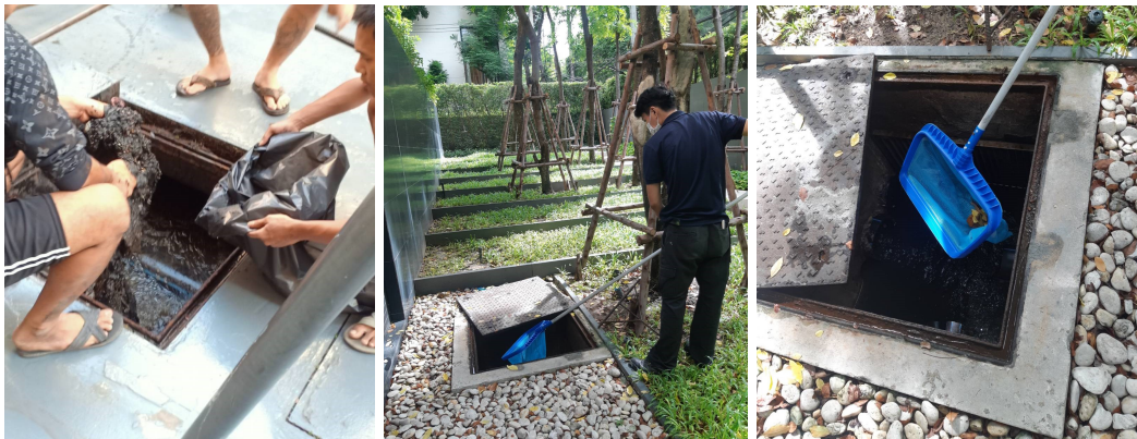
ภาพที่ 3-39 ล้างถังสำรองน้ำใช้
