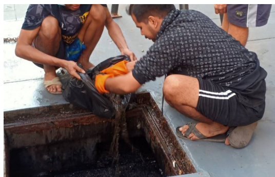
ภาพที่ 3-40 ขุดลอกที่ระบายน้ำและบ่อหน่วงน้ำ
