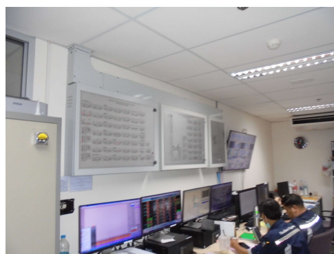
3-21 แผงควบคุมการรับส่งสัญญาณแจ้งเหตุเพลิงไหม้
