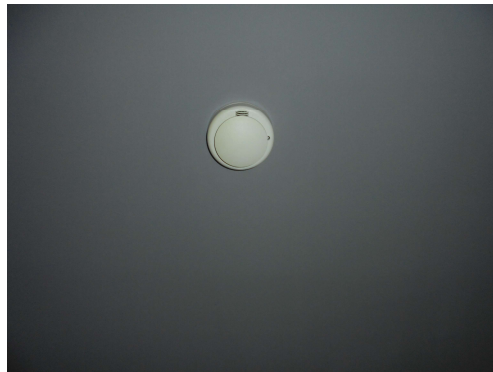
ภาพที่ 3-23 เครื่องตรวจจับความร้อน
