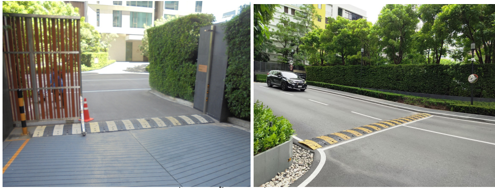
ภาพที่ 3-7 ติดตั้งสันนูนเพื่อชะลอความเร็วรถ
