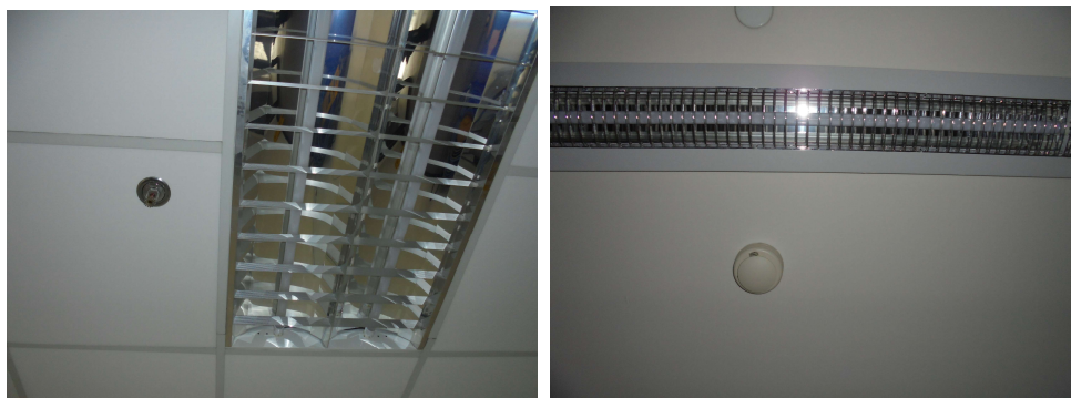
ภาพที่ 3-20 หัวกระจายน้ำอัตโนมัติและเครื่องตรวจจับควัน
