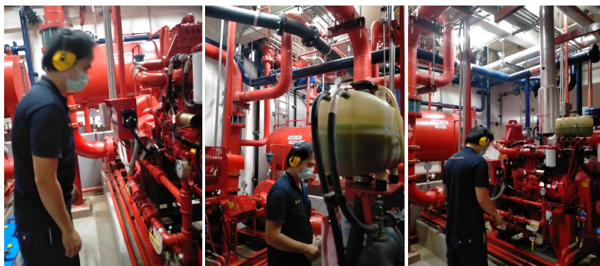
ภาพที่ 3-17 ห้องเครื่องสูบน้ำดับเพลิง และการตรวจสอบระบบFire Pump
