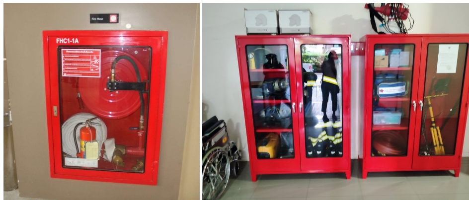
ภาพที่ 3-19 ตู้เก็บสายฉีดน้ำดับเพลิงและอุปกรณ์
